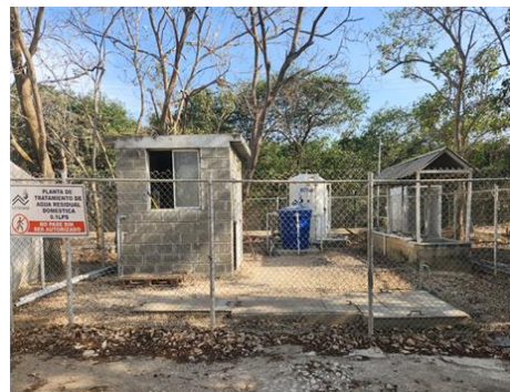
Ilustración 79. Planta de tratamiento de aguas residuales capacidad 0,12 LPS
