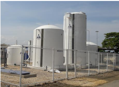
Ilustración 78. Planta de tratamiento de aguas residuales capacidad 1,12 LPS
